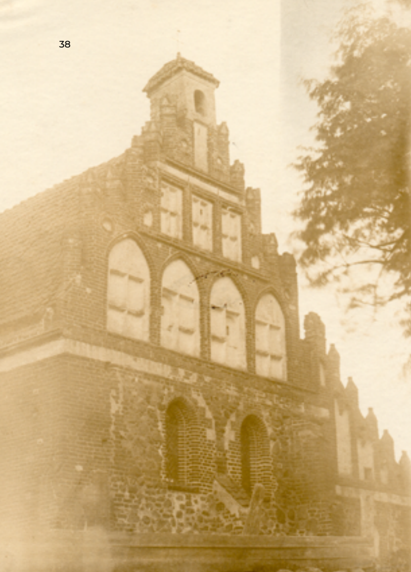
Widok dawnego kościoła w Dywitych od strony południowo-wschodniej.
